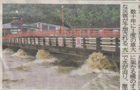
橋のすぐ下まで増水した国道53号沿いの千代川 = 7日、鳥取市用瀬町用瀬
